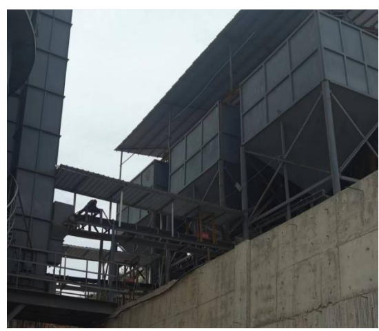
窑体废气收集管道
