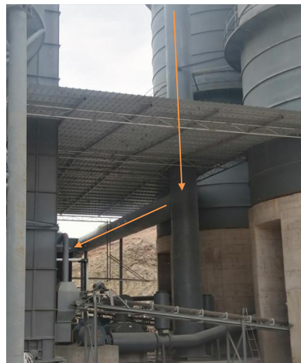
窑体废气收集管道
