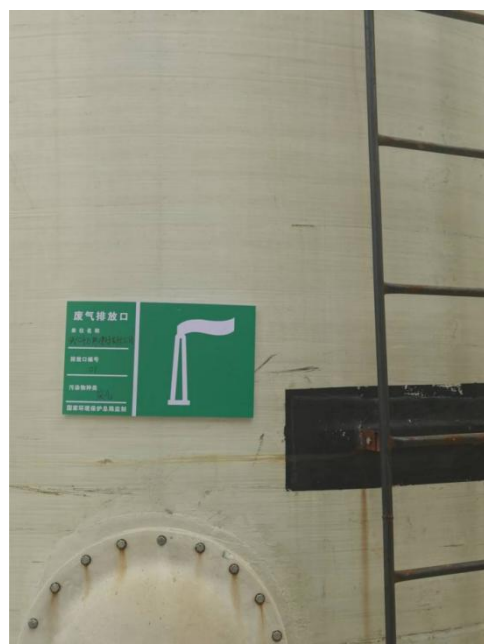
废气标识牌及排放口
